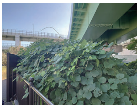
図 6. みなとのもり公園周辺のクズ群落. (11月13日撮影)
