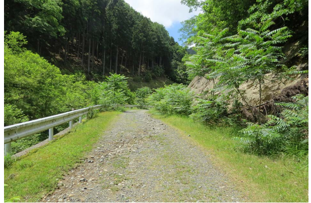
写真2 起点付近. 2018年6月1日. 路側のシンジュが成長した.
