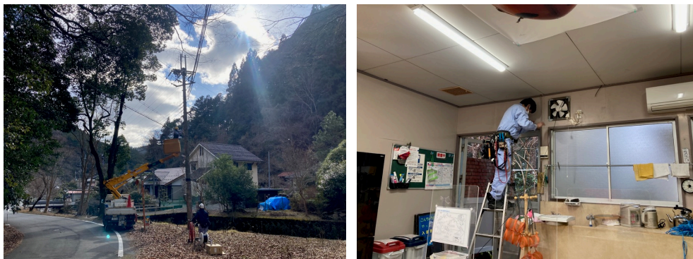
左：屋外工事（1月10日）、右：室内工事（3月21日）
